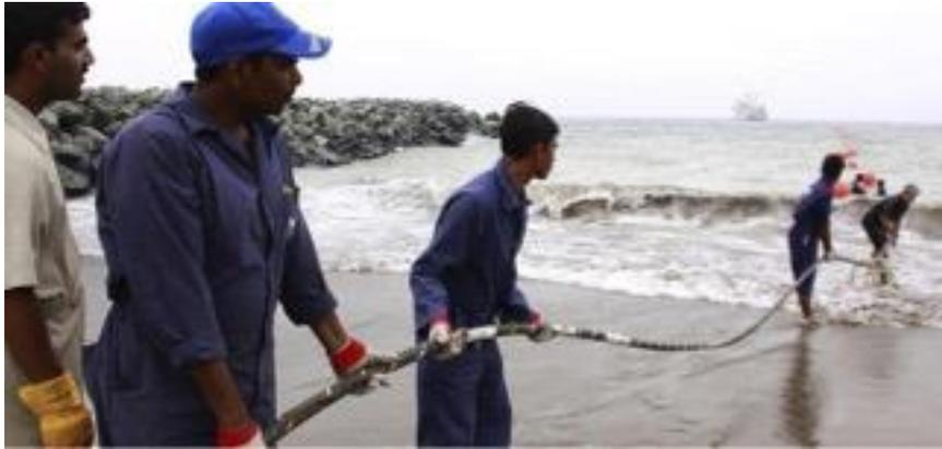
On devine, au loin, le navire qui l'a déployé au fond de l'océan. Son installation se termine toujours plus ou moins comme ceci : tracté sur une plage, enfoui, puis relié à la « station d'atterrissage ». Le cœur d'un câble optique, la « fibre », est en silice (du verre) et a le diamètre d'un cheveu (pour tout savoir sur ces câbles, nous proposons de suivre la très intéressante conférence de Bruno Vinouze<sup>1</sup> – installez-vous bien, elle dure 1h30).
